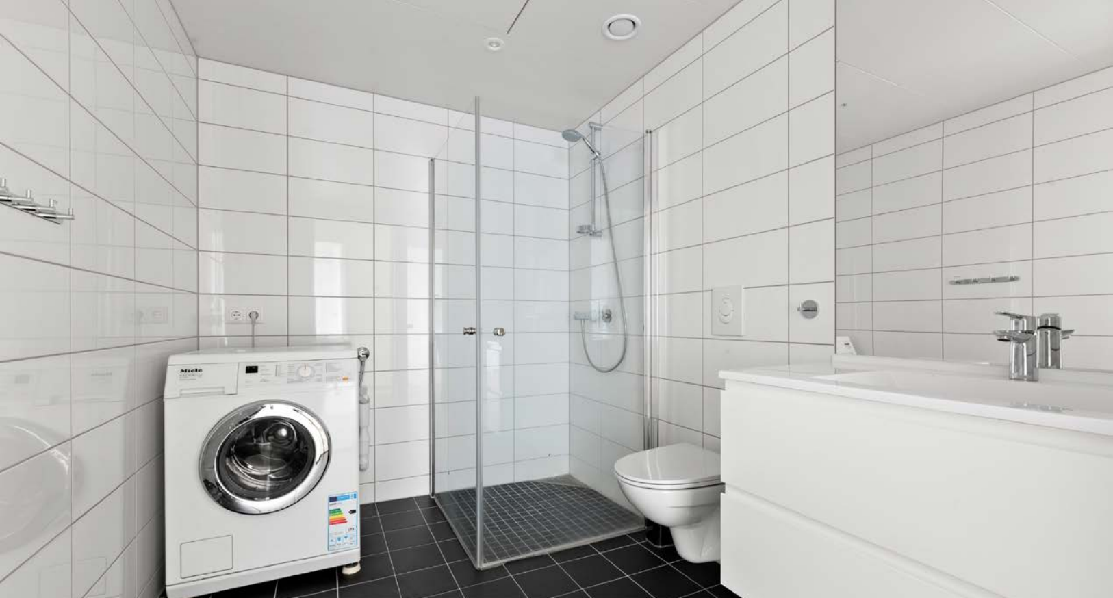
Bad med opplegg til vaskemaskin
