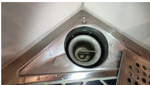
Kontroll av sluk.
