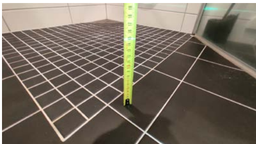
Kontroll av fallforhold.
