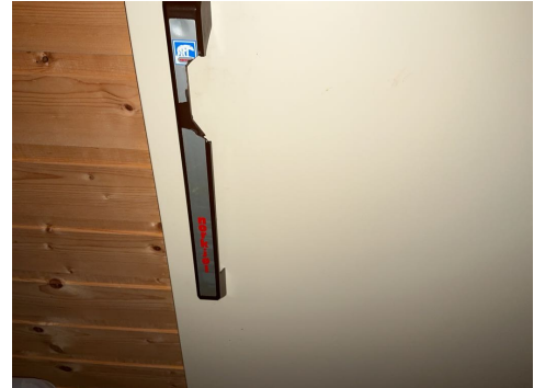
Knust håndtak på kjøleromsdør
