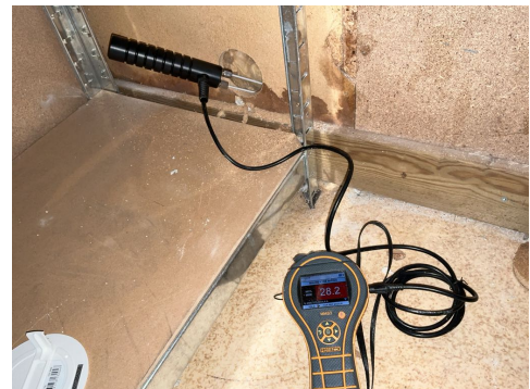
Sted for fuktsøk.
