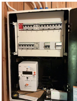
Sikringsskap med automatsikringer
