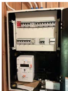
Sikringsskap med automatsikringer
