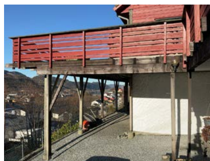
Terrasse på underliggende søyler/ bjelker.
