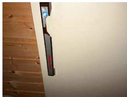
Knust håndtak på kjøleromsdør
