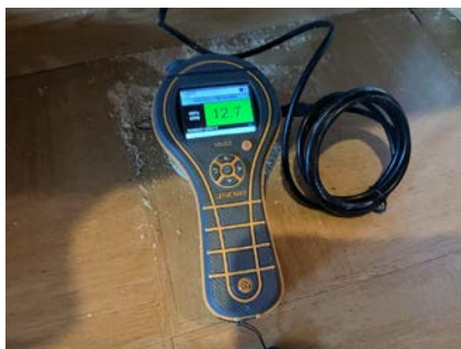
Fuktsøk i påforet vegg mot blindkjeller, resultat grønn sone, tørr
