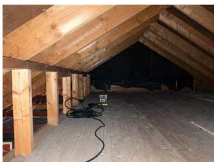
Noe retningsavvik er observert i mellom de ulike konstruksjonsdeler, ulike byggeår for tilbygg/ ombygging.
