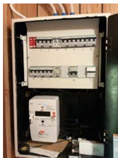
Sikringsskap med automatsikringer
