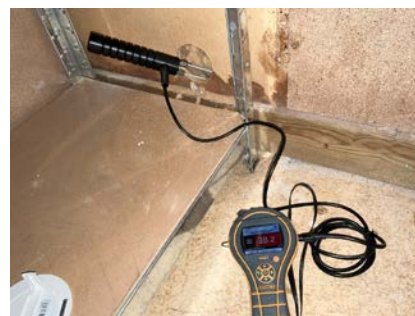
Sted for fuktsøk.
