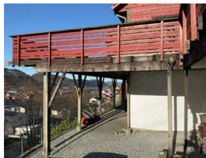
Terrasse på underliggende søyler/ bjelker.
