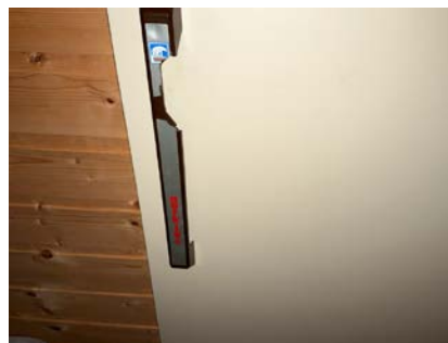
Knust håndtak på kjøleromsdør
