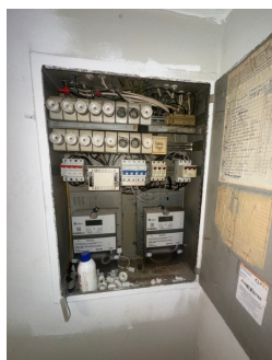
Sikringsskap med automatsikringer.
