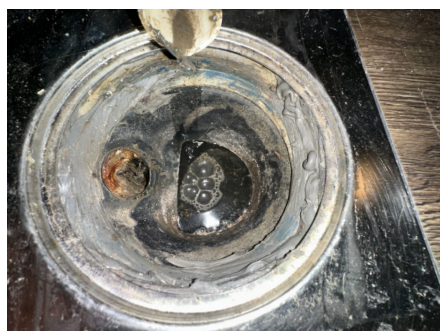
Sprekk i fuger på bad
