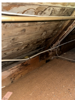
Det er påvist fukt-/råteskader i takkonstruksjonen.
