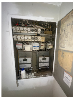
Sikringsskap med automatsikringer.
