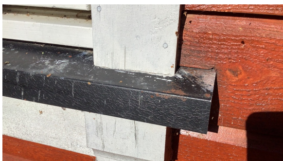
Omramming er ført helt ned til vannbrett.
