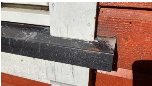
Omramming er ført helt ned til vannbrett.
