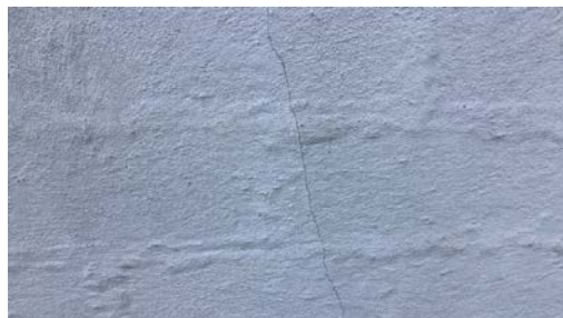
Skråriis i murvegg.
