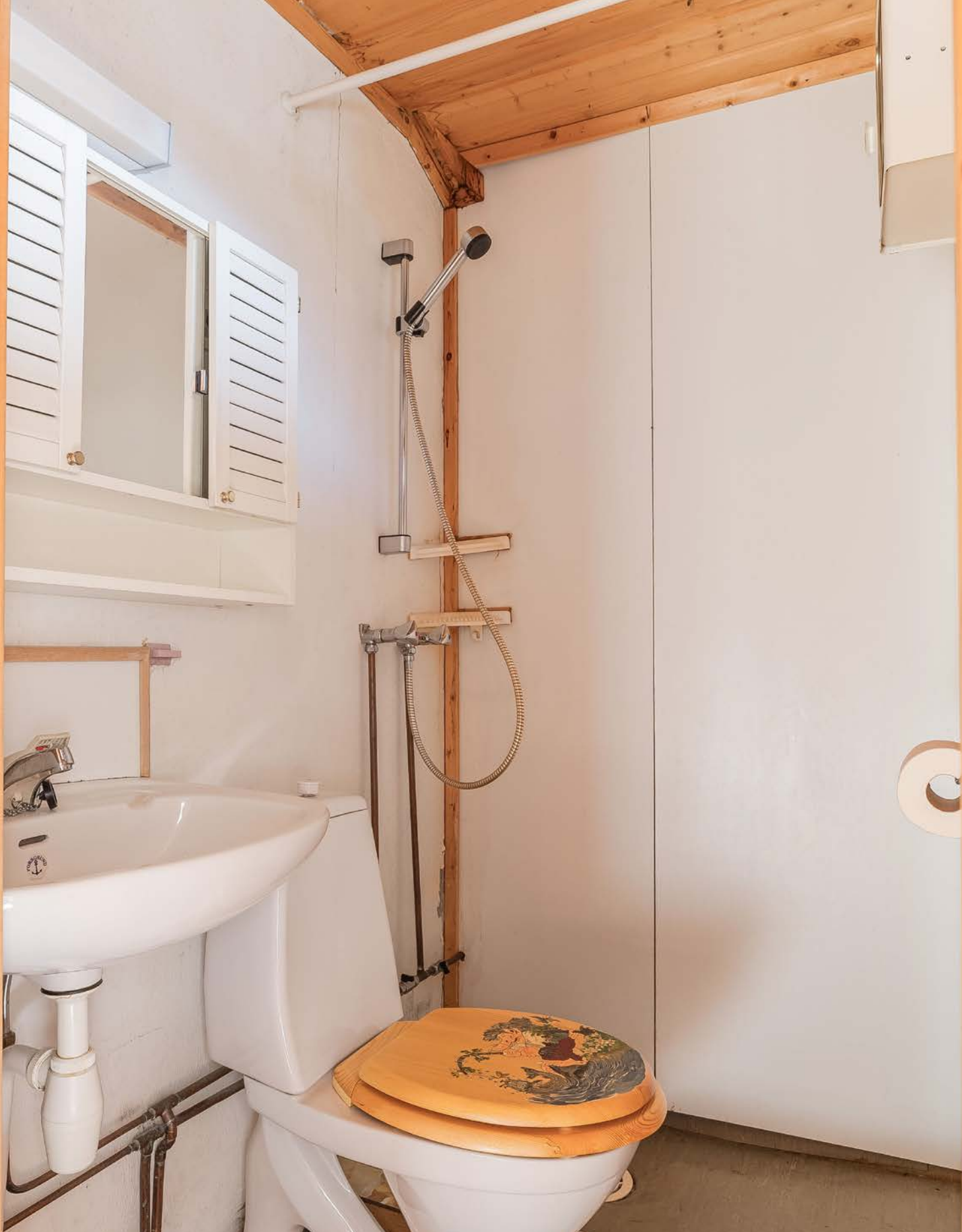
Eldre baderom som må oppgraderes for å tåle normal bruk etter dagens krav. Baderommet har belegg på gulv, våtromsplater på veggene og oppvarming med panelovn.
