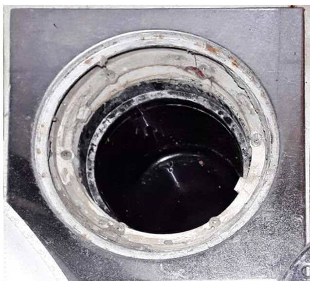
Våtrom - [Sluk vaskerom]
