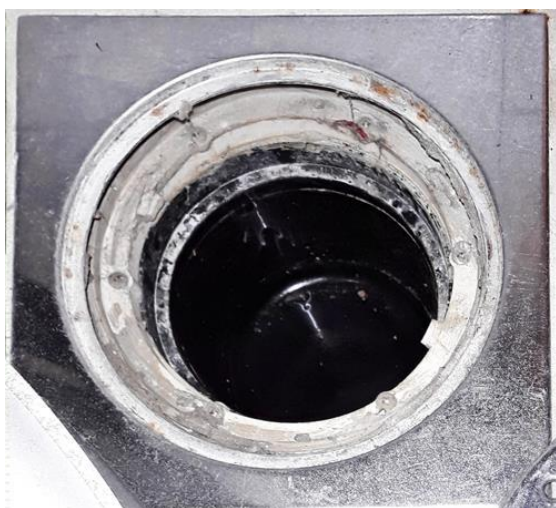
Våtrom - [Sluk vaskerom]
