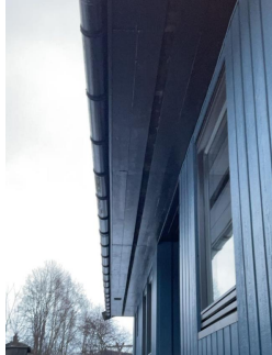
Synlig ventilering i raftekasse ved overgang tak/vegg
