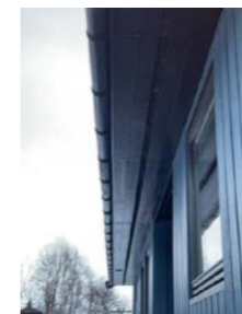
Synlig ventilering i raftekasse ved overgang tak/vegg
