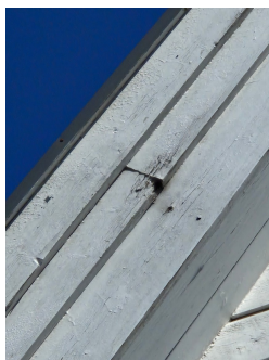
Ingen oppkant bak kledning eller beslag.
