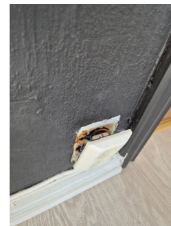
Ledning som ikke er tilstrekkelig festet.
