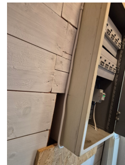
Ledning som ikke er tilstrekkelig festet.
