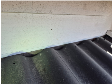
Ingen oppkant bak kledning eller beslag.
