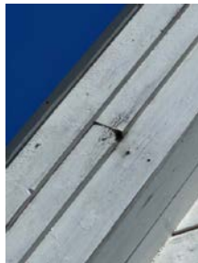
Ingen oppkant bak kledning eller beslag.
