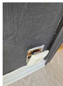
Ledning som ikke er tilstrekkelig festet.
