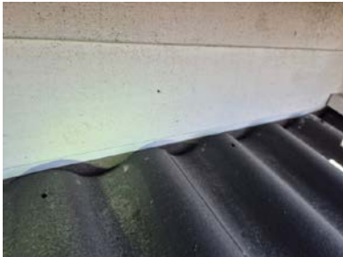
Ingen oppkant bak kledning eller beslag.
