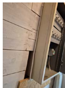
Ledning som ikke er tilstrekkelig festet.
