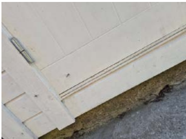
Kjellerdør har ingen beslag i nedre del.
