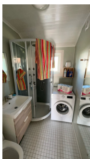
Dusjkabinett og opplegg for vaskemaskin.
