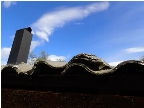
Skader i plater.
