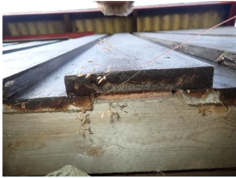
Begrenset lufting bak kledning.
