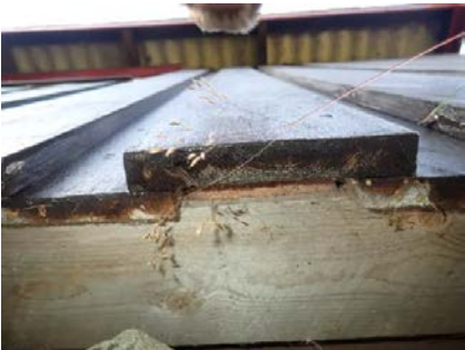
Begrenset lufting bak kledning.
