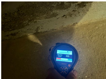
Fuktkontroll på gulv ved grunnmur mot øst
