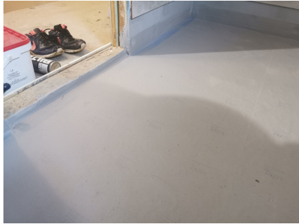
Vanntett oppbrett på membran under dør
