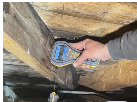
Bilde fra 2025 fuktkontroll, tørt på befaringsdagen
