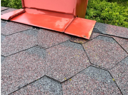
Sokkelbeslag på pipe er ikke tilfredsstillende skrudd fast i taket.
