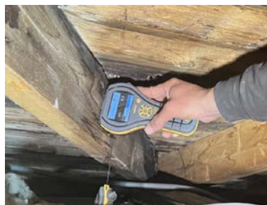
Bilde fra 2025 fuktkontroll, tørt på befaringsdagen
