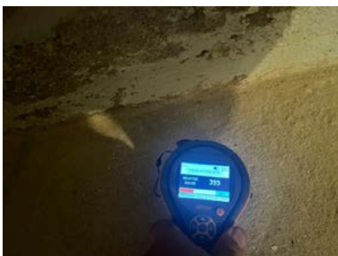
Fuktkontroll på gulv ved grunnmur mot øst
