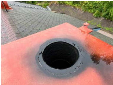
Ikke montert topp avdekning
