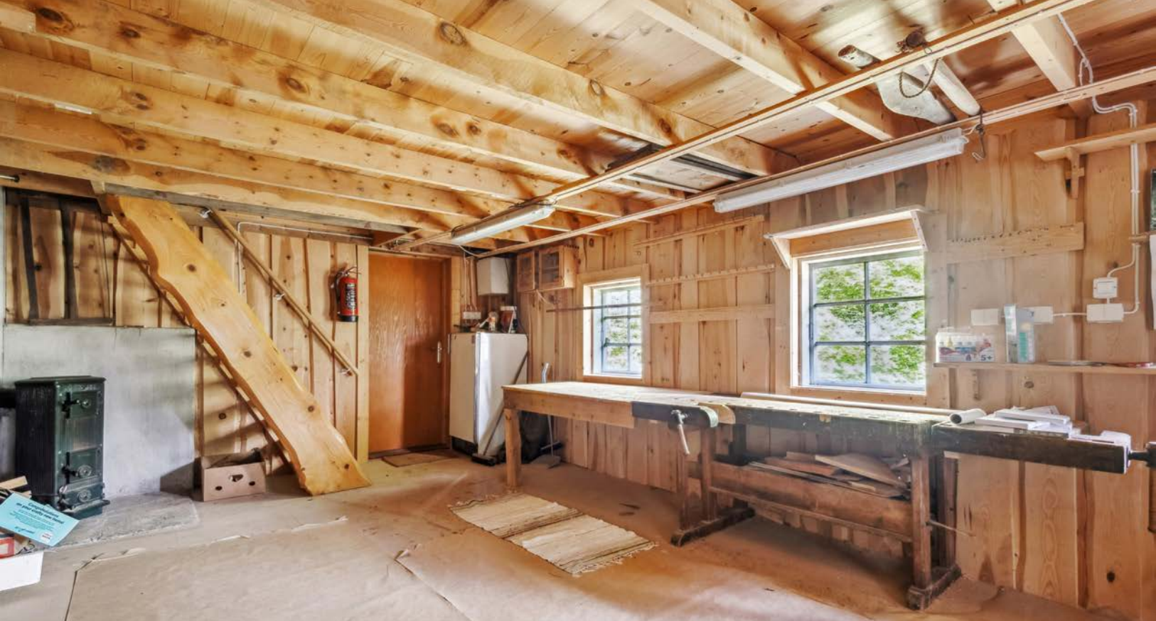
Det er innlagt vann og strøm til verkstedet.
