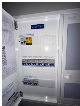
Sikringsskap med automatsikringer.
