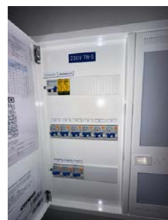
Sikringskap med automatsikringer.
