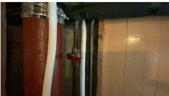
Stoppekran til leilighet, testet.
