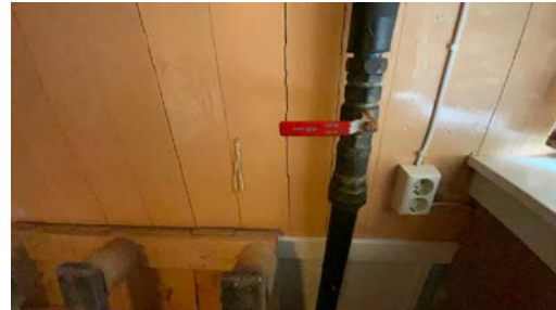
Stoppekran til flere leiligheter. testet.
