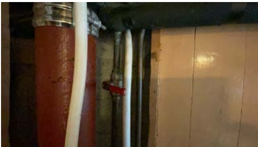
Stoppekran til leilighet, testet.
