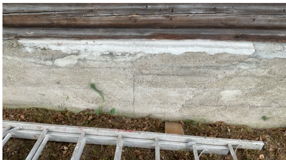
Det er foretatt lokale utbedringer på grunnmur.
