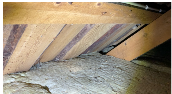
Isolert helt ut mot undertak.
