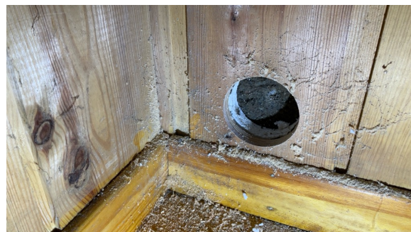
Isopor mot grunnmur bak panel
