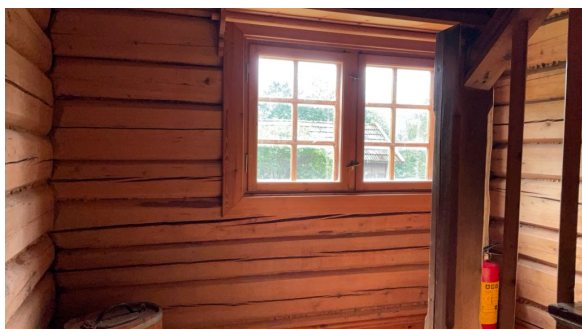
Vindu i gangretning.
