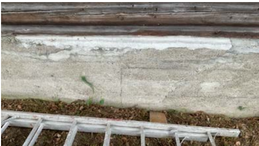
Det er foretatt lokale utbedringer på grunnmur.
