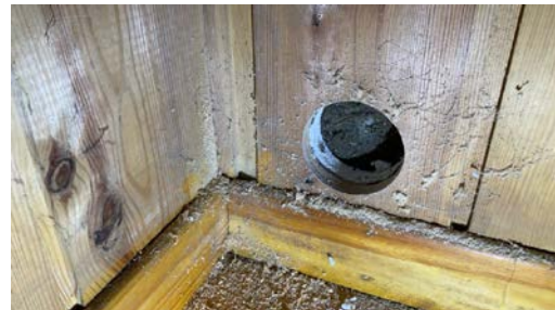
Isopor mot grunnmur bak panel
