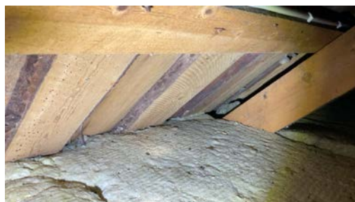
Isolert helt ut mot undertak.
