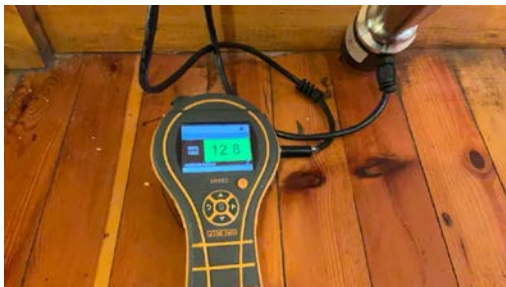
Fuktmåling i treverk i kjeller.
