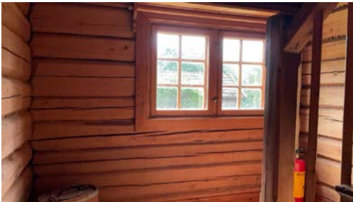
Vindu i gangretning.
