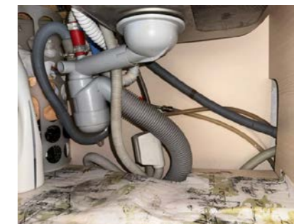
Rørøpplagg i kjøkkenbenk
