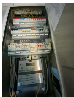
Sikringsskap på hybel med egen måler.
