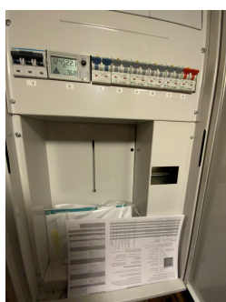
Sikringsskap på hybel med egen måler.
