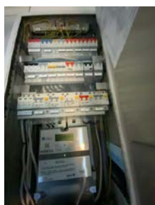
Sikringsskap på hybel med egen måler.
