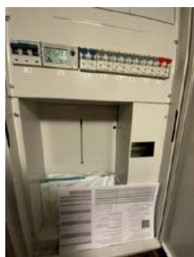
Sikringsskap på hybel med egen måler.
