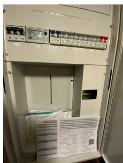
Sikringsskap på hybel med egen måler.
