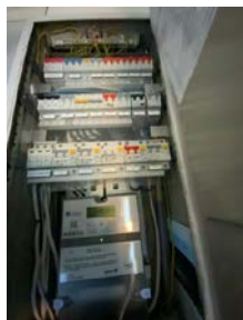
Sikringsskap på hybel med egen måler.
