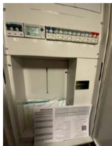
Sikringsskap på hybel med egen måler.
