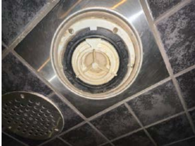
Sluk i plast, plassert i dusjnisje
