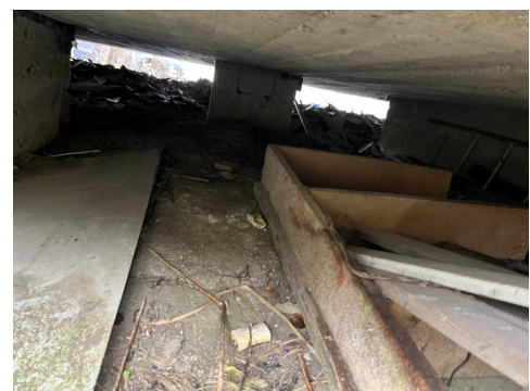
Åpent kryperom i murkonstruksjoner.
