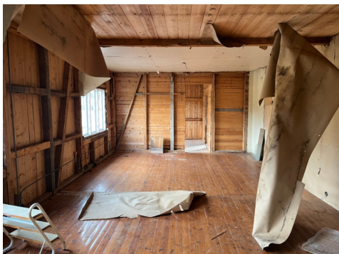
2.etasje med åpne veggkonstruksjoner.
