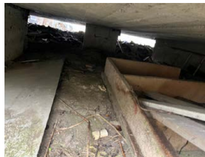
Åpent kryperom i murkonstruksjoner.
