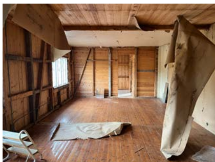
2.etasje med åpne veggkonstruksjoner.
