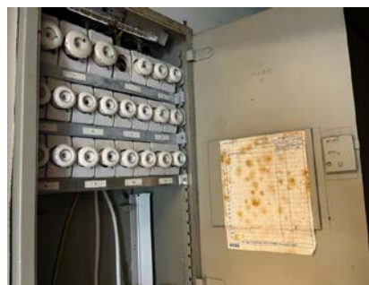
Sikringsskap 1.etasje.
