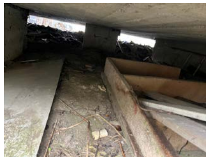
Åpent kryperom i murkonstruksjoner.
