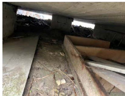
Åpent kryperom i murkonstruksjoner.
