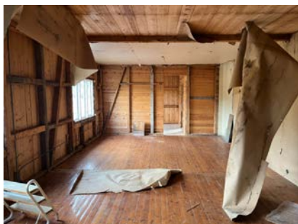
2.etasje med åpne veggkonstruksjoner.
