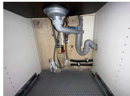
Røropplegg i kjøkkenbenk med Waterguard
