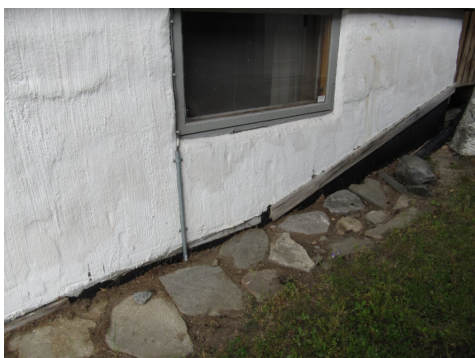
Knotteplast mangler topplst
