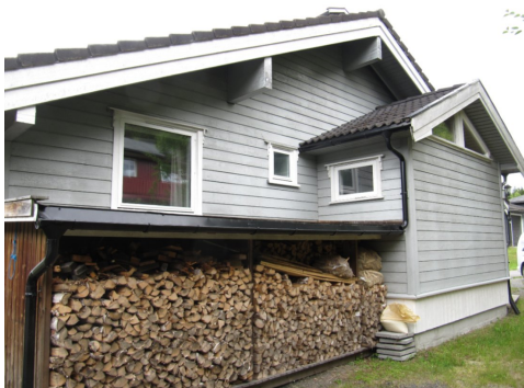
Tilbygg og vedlager.
