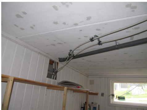
Provisorisk løsning med vann til kjøkken.
