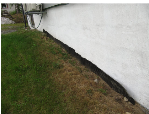
Knotteplast mangler topplst
