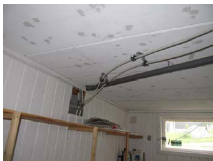
Provisorisk løsning med vann til kjøkken.
