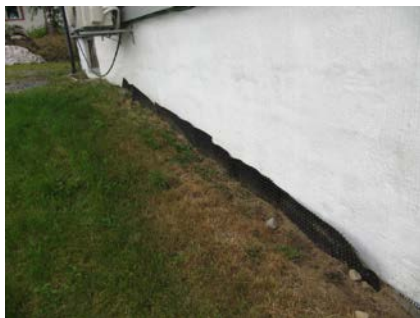
Knotteplast mangler topplst
