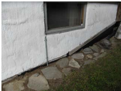
Knotteplast mangler topplst
