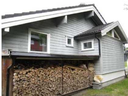
Tilbygg og vedlager.
