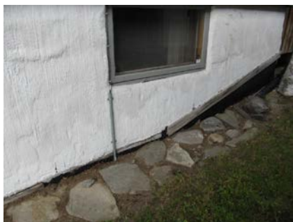
Knotteplast mangler topplst
