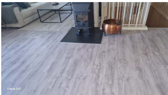
Nytt gulv i stue, gang og kjøkken.
