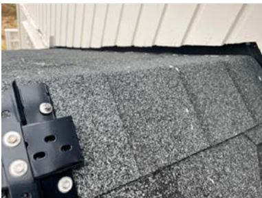
Kort avstand fra tak til underkant av kledning
