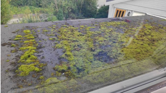
Bilde fra befaring den 07.09.2023.
