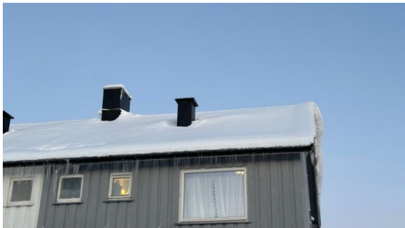
Ved befaring den 06.01.2025 var taket snødekt.
