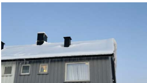
Ved befaring den 06.01.2025 var taket snødekt.
