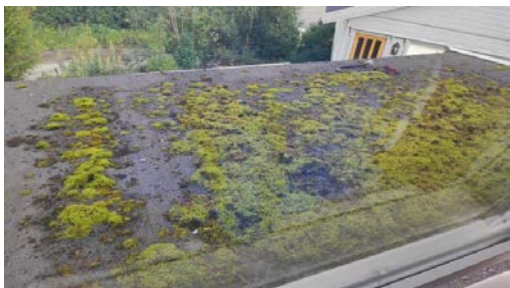
Bilde fra befaring den 07.09.2023.
