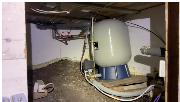
Fra kryprom var det isolert vegger med montert hovedvannledning og trykktank
