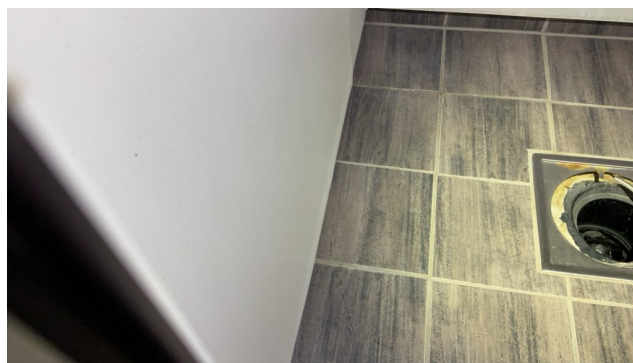
Svellet plater i nedre del, manglende lister og ikke kjent konstruksjonsoppbygging
