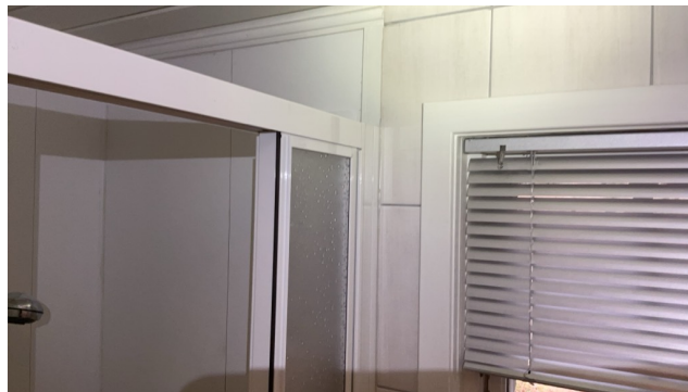
Svellet plater i nedre del, manglende lister og ikke kjent konstruksjonsoppbygging
