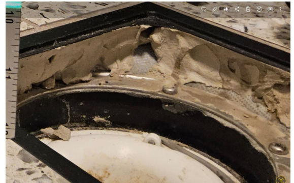
Bilde ved befaring
