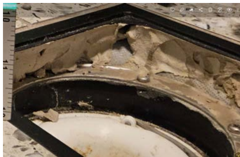
Bilde ved befaring
