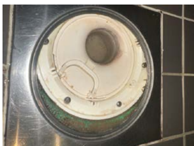
Sluk i plast, plassert i dusjnisse
